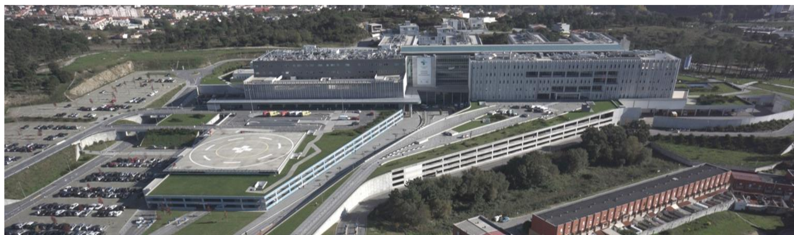
Fot. 1 - Hospital de Braga.
